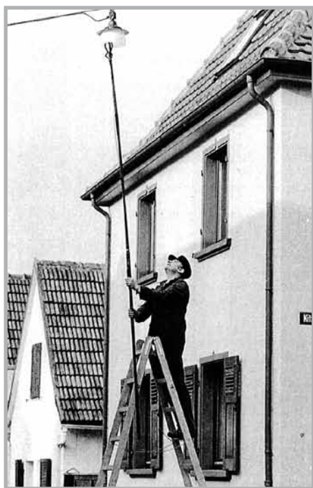
Auswechseln der Glühbirnen – mit dem Birnengreifer bei der Arbeit
